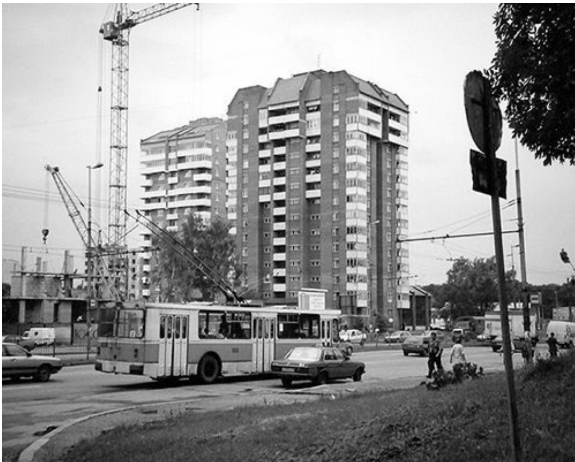
A arquitetura soviética foi marcada pelas novostroiki (“Novas Construções”) após a Segunda Guerra Mundial. Conjuntos habitacionais de estilo contemporâneo, esses prédios são criticados pelos que apreciam as construções históricas do centro de Moscou.
