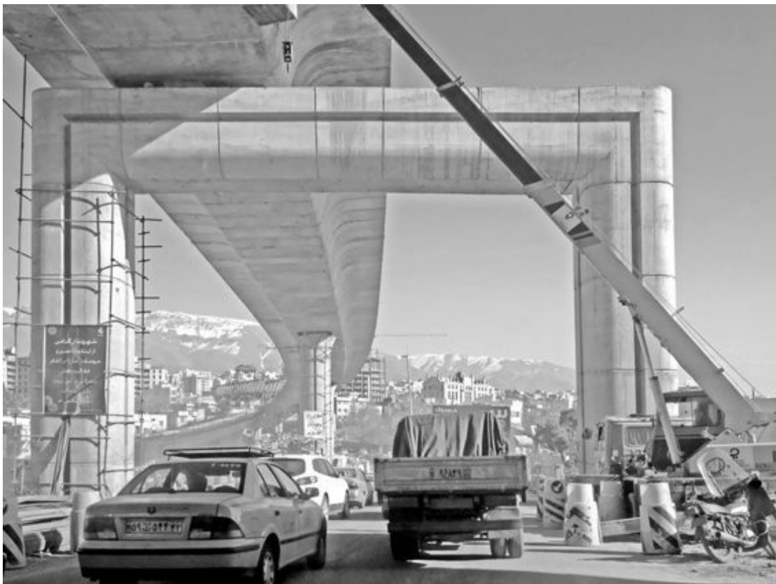
Obra para construção do viaduto Sadr, que foi inaugurado em 2013 e ajudou a desafogar o trânsito a norte e leste de Teerã. O Irã é conhecido como “país de engenheiros”.
