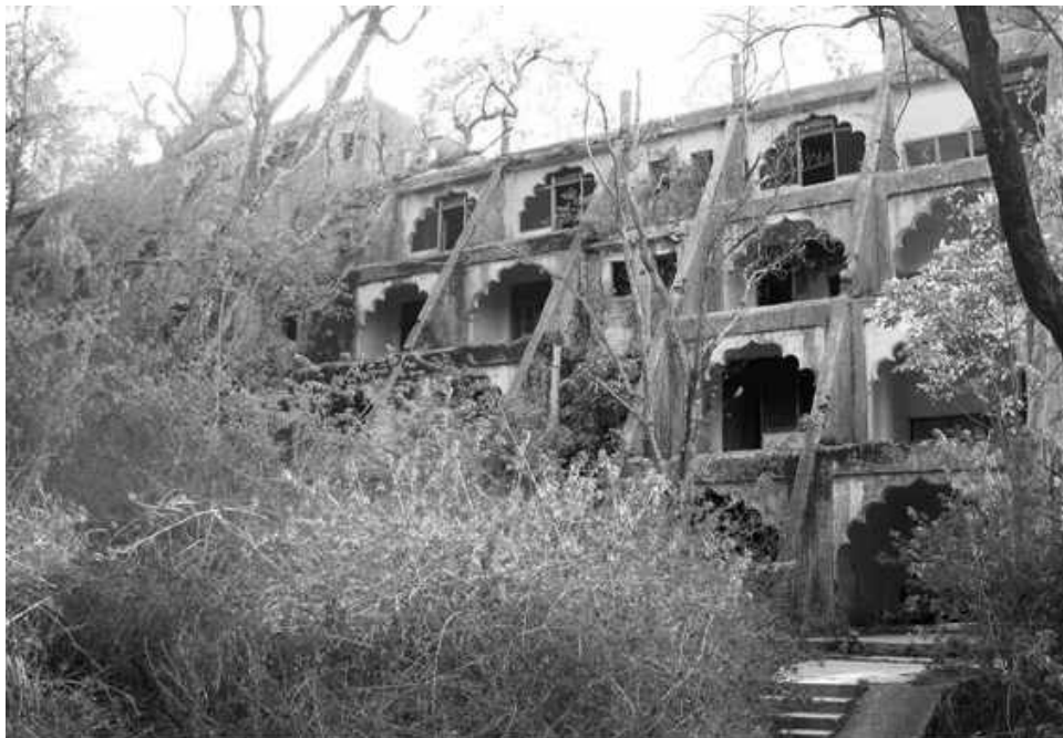
Prédio principal do ashram de Maharishi Mahesh Yogi onde os Beatles se hospedaram. Hoje está coberto pelo matagal.
